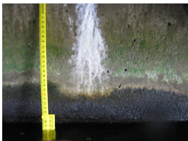
Figuur 4.21: STP03 oost, scheur boven waterlijn met klalkuitbloeding
