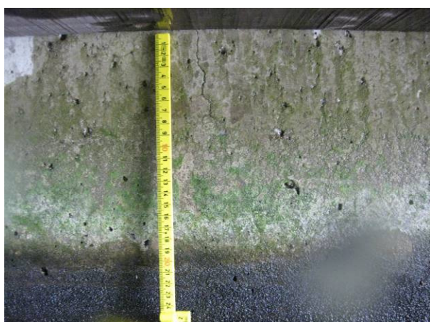
Figuur 4.20: STP03 west, scheur boven waterlijn
