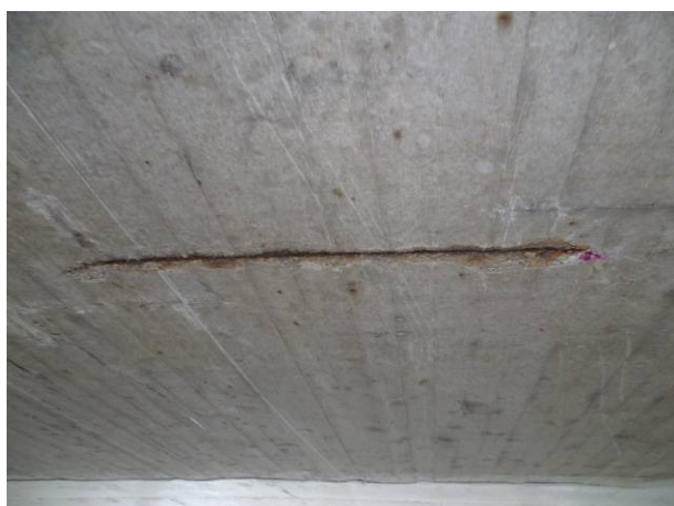
Figuur 4.12: Betonschade onderzijde dek, oorzaak lokaal te lage dekking.
