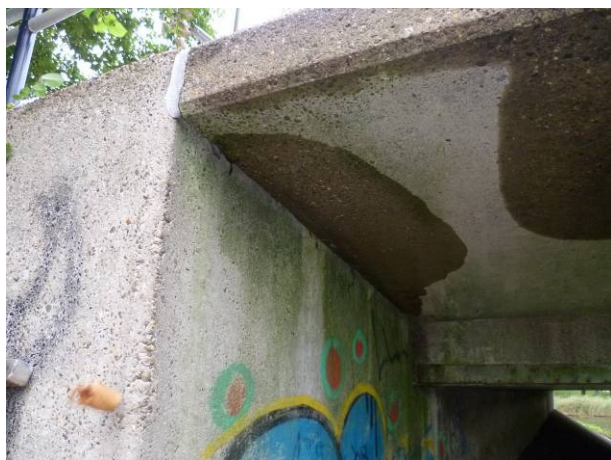
Figuur 4.14: Lekkages via voegen schampkant zuidzijde.
