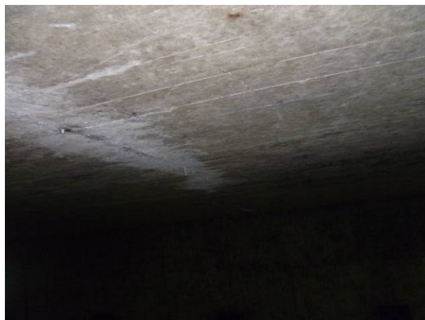
Figuur 4.8: Scheurvorming onderzijde dek.
