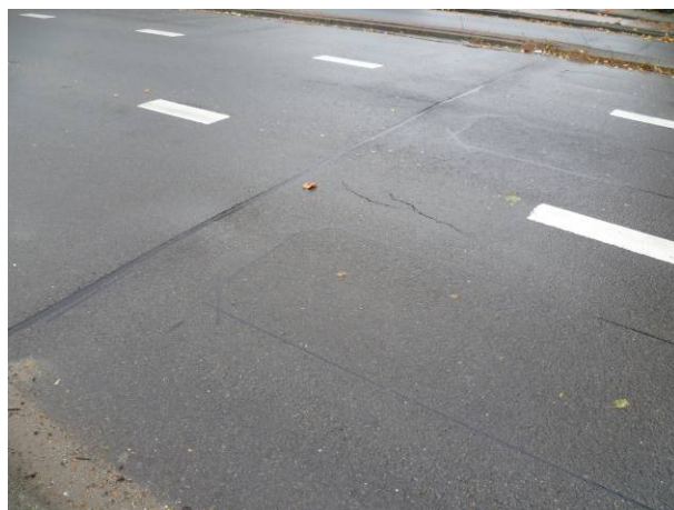
Figuur 4.2: Asfaltconstructie in langsrichting gescheurd en plaatselijk verzakt.
