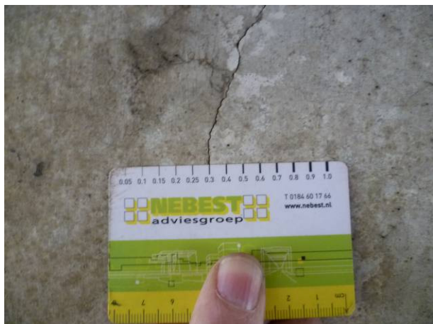
Figuur 4.18: Scheurwijdte 0,3 mm STP02
