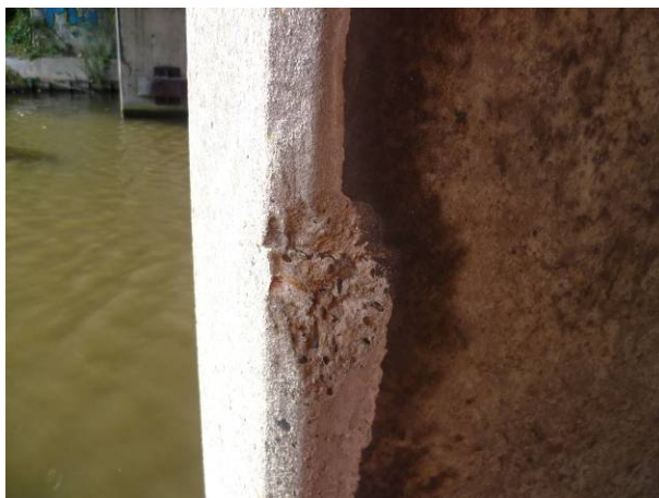
Figuur 4.23: Betonschade mechanisch STP03
