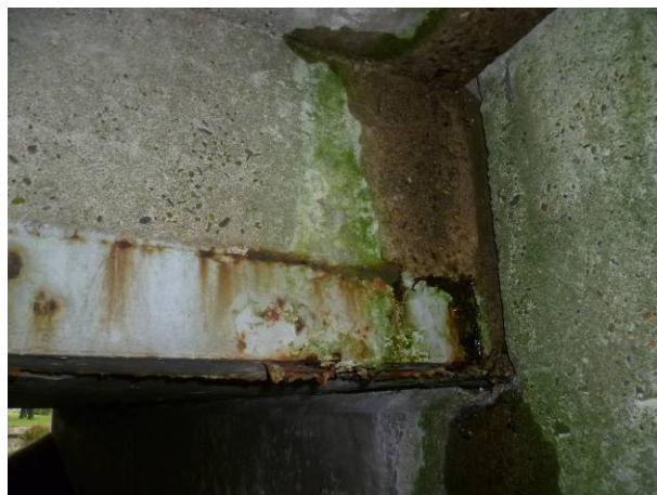
Figuur 4.11: Stalen hoekprofiel, conservering verouderd en gecorrodeerd.
