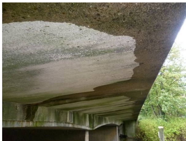
Figuur 4.15: Overslaand hemelwater schampkant zuidzijde.
