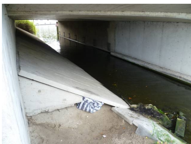
Figuur 4.27: Taludbekleding oostzijde onderspoeld/ondergraven.
