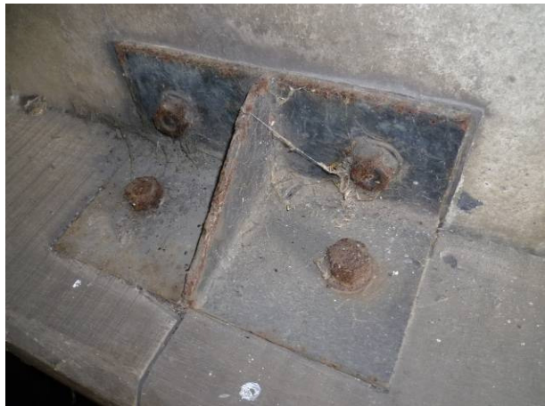
Figuur 4.30: Corroderende bevestigingsplaten wrijfgording
