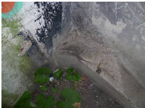
Figuur 4.22: Betonschade met corrosie wapening STP01
