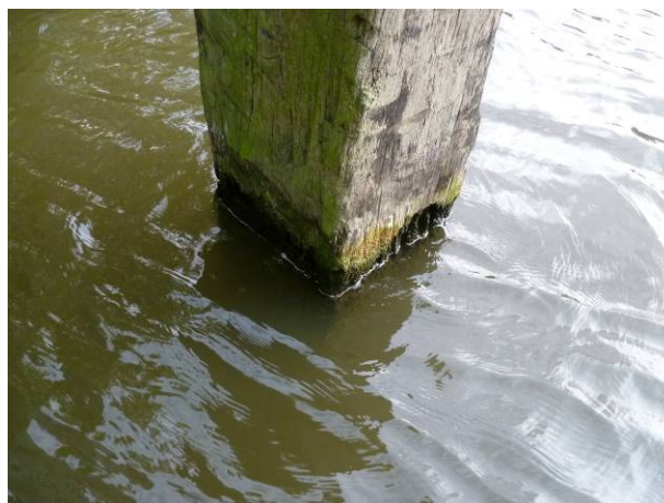
Figuur 4.29: Houten palen dukdalven, aangetast ter hoogte van waterlijn, dikteafname circa 3 cm per zijde.
