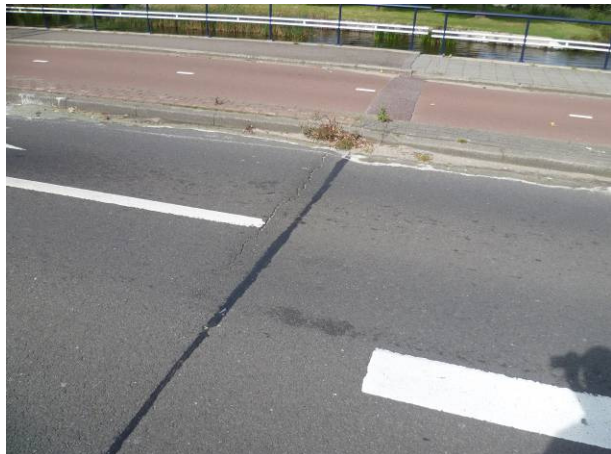
Figuur 4.3: Asfaltconstructie verzakt en ter plaatse van overgang gescheurd.
