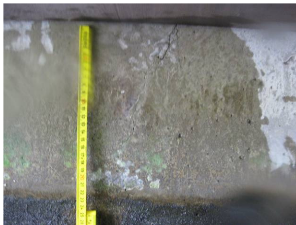
Figuur 4.19: STP02 west, scheur boven waterlijn
