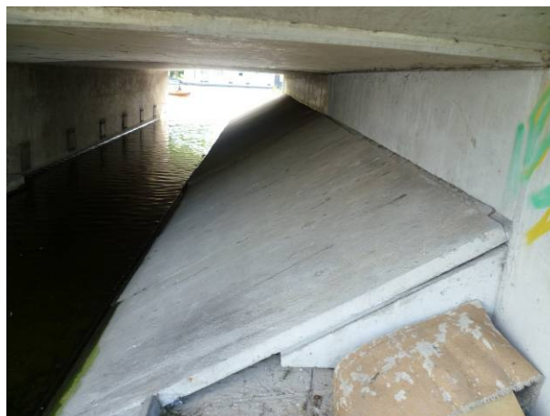
Figuur 4.26: Taludbekleding westzijde onderspoeld/ondergraven.
