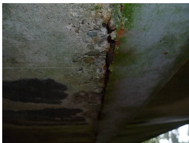
Figuur 4.13: Betonschade veroorzaakt door corrosie hoekprofiel.
