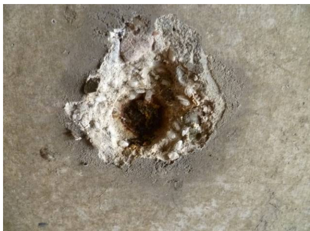
Figuur 4.24: Losse/uitgedrukte conusvulling STP02
