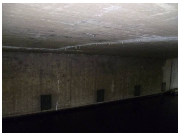
Figuur 4.9: Scheurvorming met kalkuitbloeding onderzijde dek.
