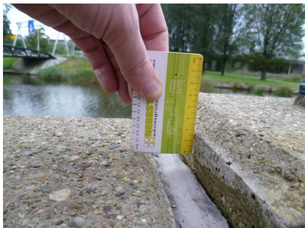
Figuur 4.6: Hoogteverschil brugdek en grondkerende constructie.
